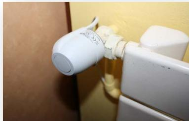
Vanne thermoélectrique filaire installée sur un radiateur
