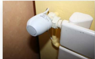
Vanne thermoélectrique filaire installée sur un radiateur
